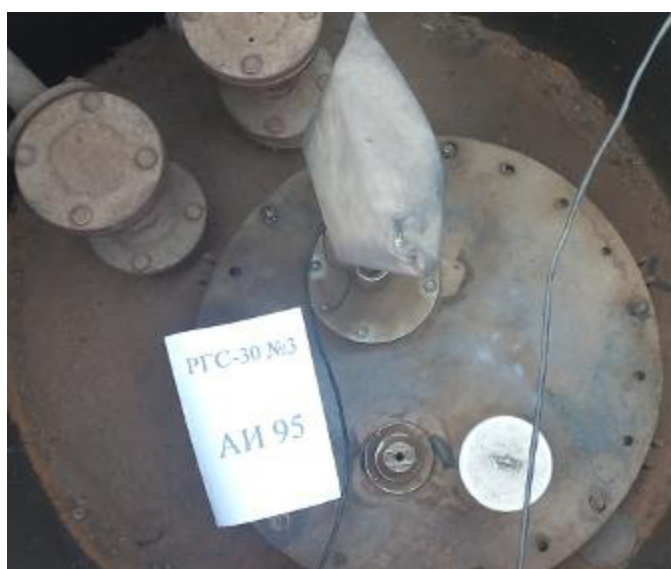
Рисунок 2 – Горловины резервуаров РГС-30 зав.№№ 3, 4
