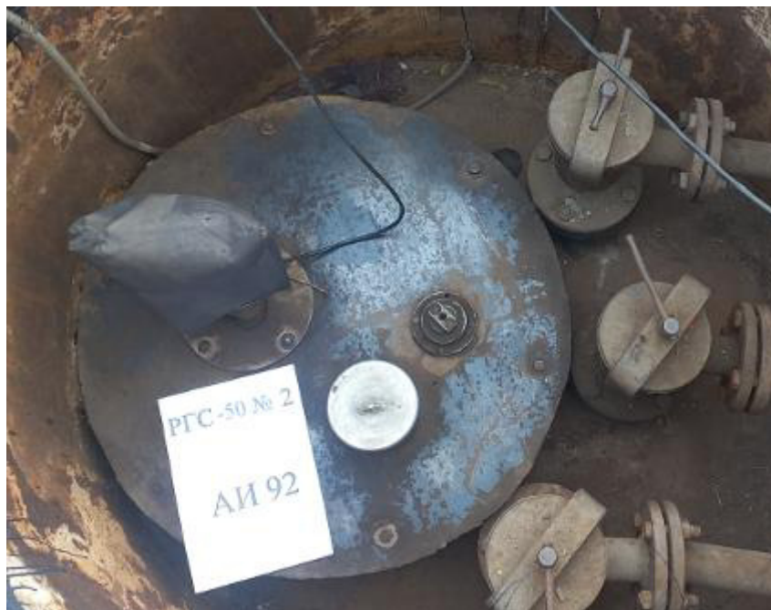
Рисунок 3 – Горловина резервуара РГС-50 зав.№ 2
