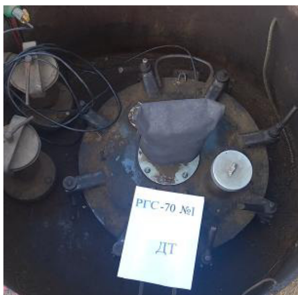
Рисунок 4 – Горловина резервуара РГС-70 зав.№ 1
