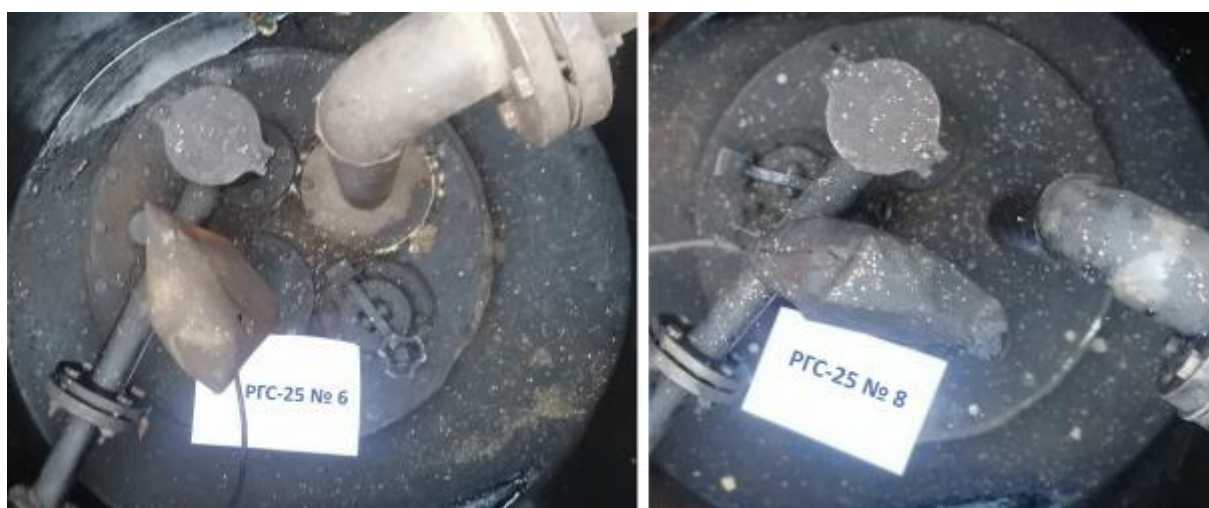
Рисунок 5 – Горловины резервуаров РГС-25 зав.№№ 6, 8
