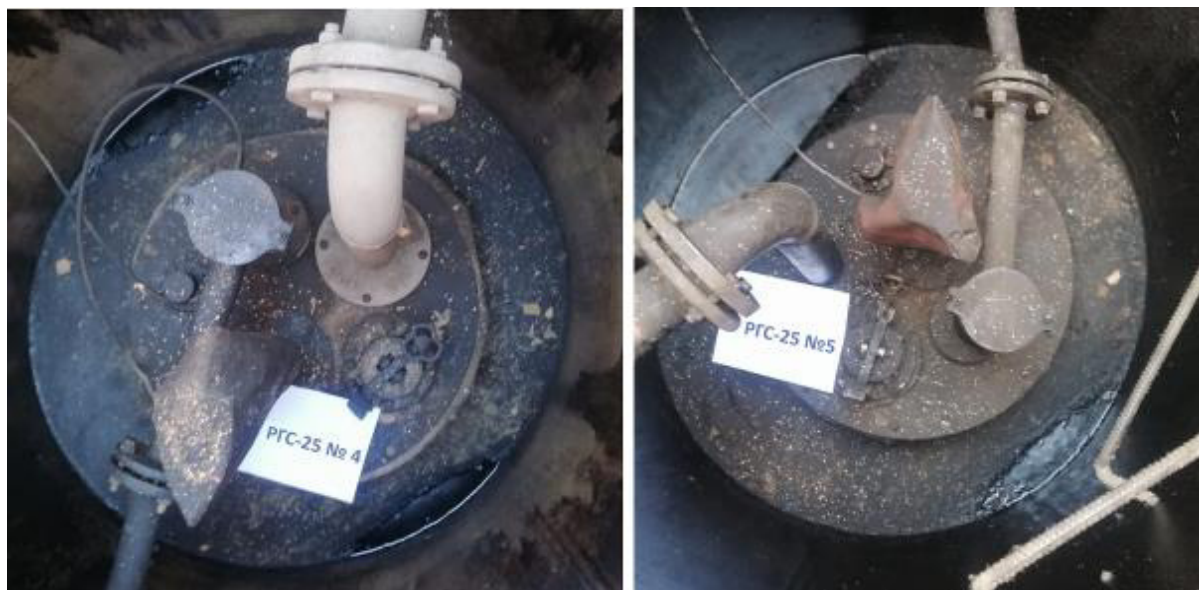
Рисунок 4 – Горловины резервуаров РГС-25 зав.№№ 4, 5
