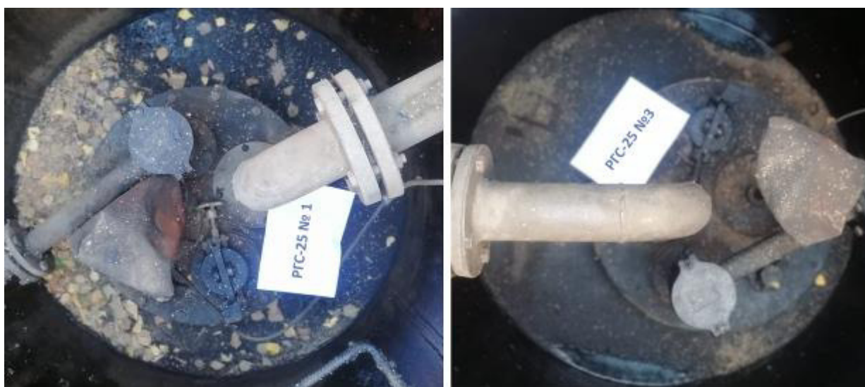
Рисунок 3 – Горловины резервуаров РГС-25 зав.№№ 1, 3
