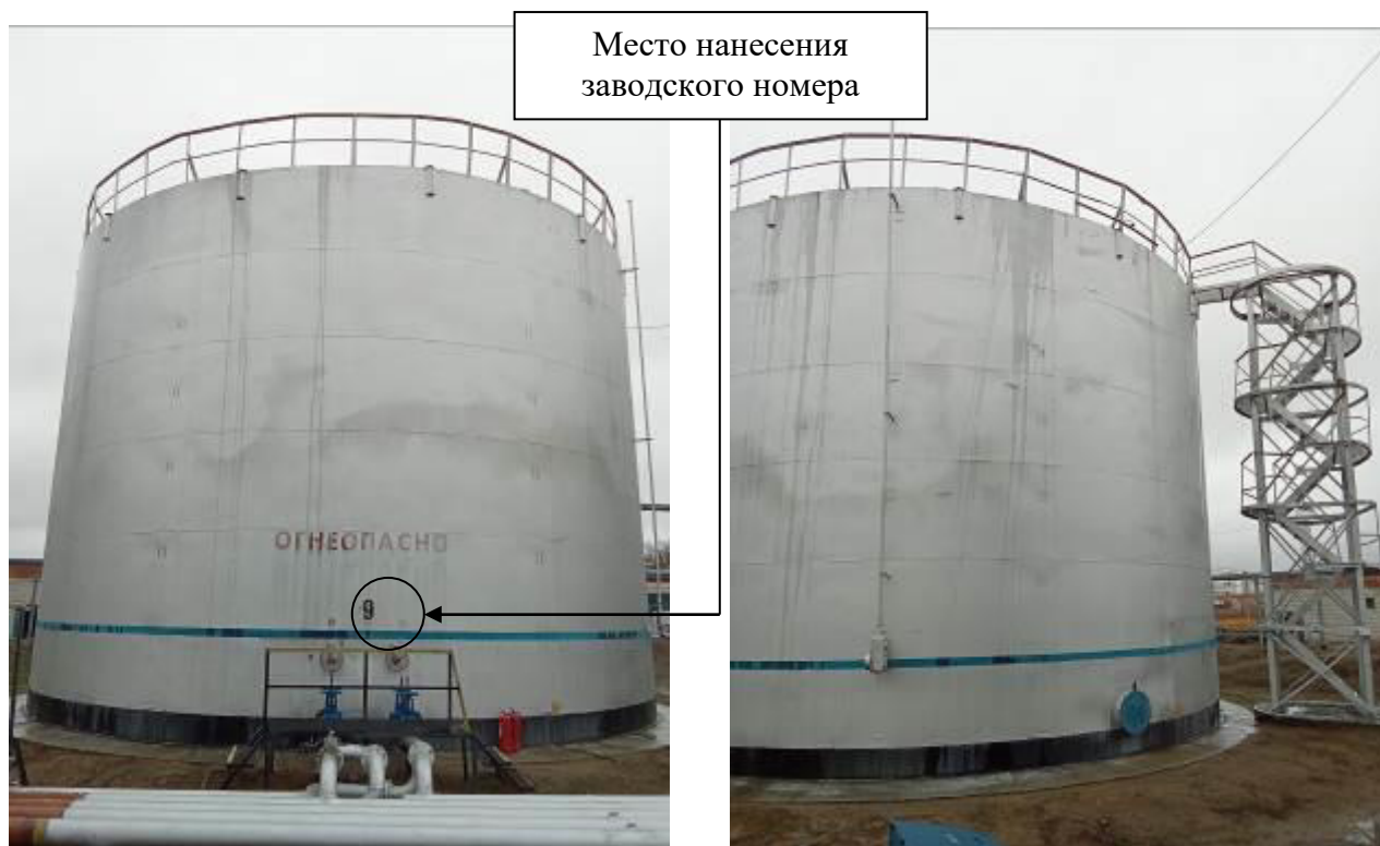
Р и с у н о к 1 – Общий вид резервуара и места нанесения заводского номера
