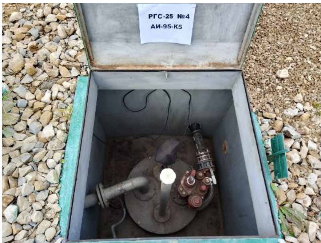
Рисунок 5 – Горловина резервуара РГС-25 зав.№ 4
