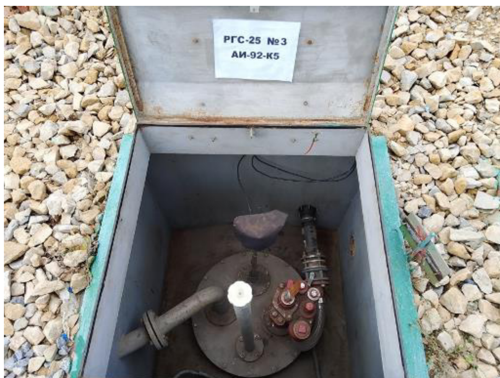
Рисунок 4 – Горловина резервуара РГС-25 зав.№ 3
