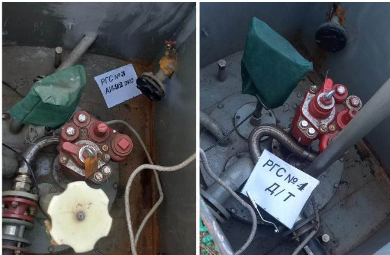
Рисунок 3 – Горловины резервуаров РГС-50 зав.№№ 3, 4
