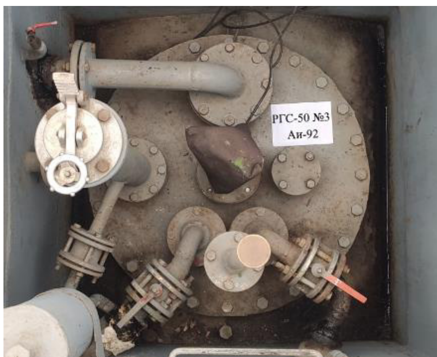
Рисунок 6 – Горловина резервуара РГС-50 зав.№ 3
