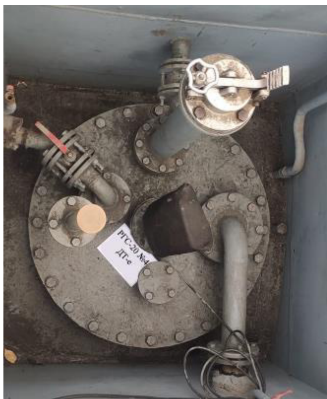
Рисунок 2 – Горловина резервуара РГС-20 зав.№ 4
