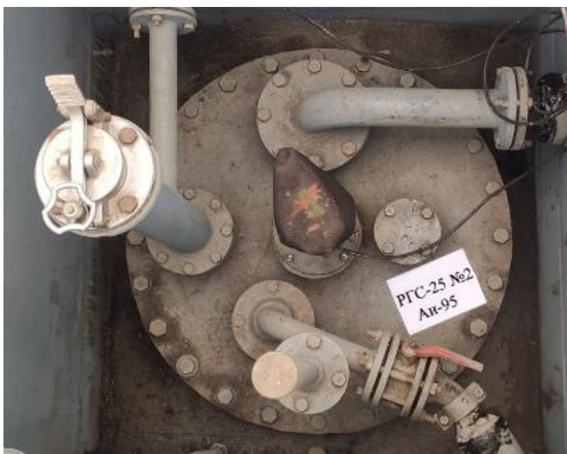
Рисунок 3 – Горловина резервуара РГС-25 зав.№ 2
