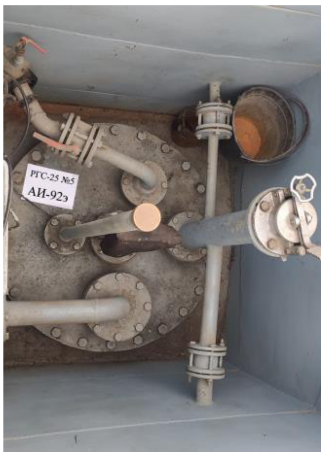
Рисунок 4 – Горловина резервуара РГС-25 зав.№ 5
