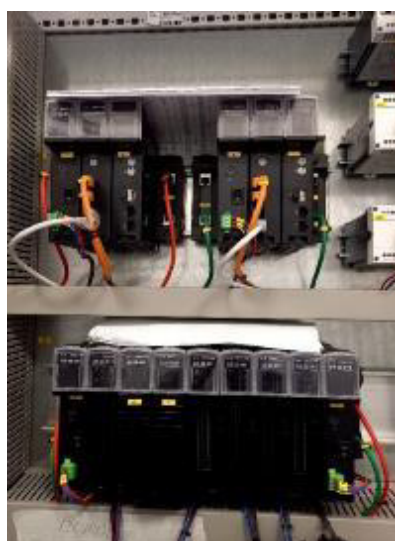
Рисунок 3 – Оборудование в контроллерных шкафах
