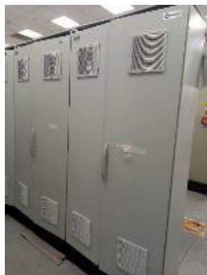
Рисунок 1 – Общий вид контроллерных шкафов
