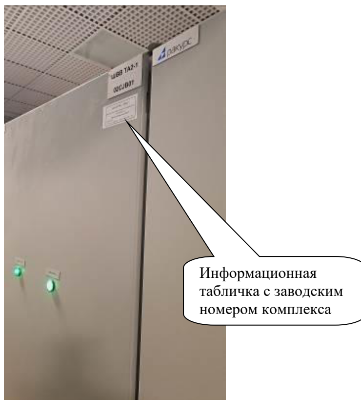
Рисунок 4 – Место нанесения информационной таблички с заводским номером комплекса
