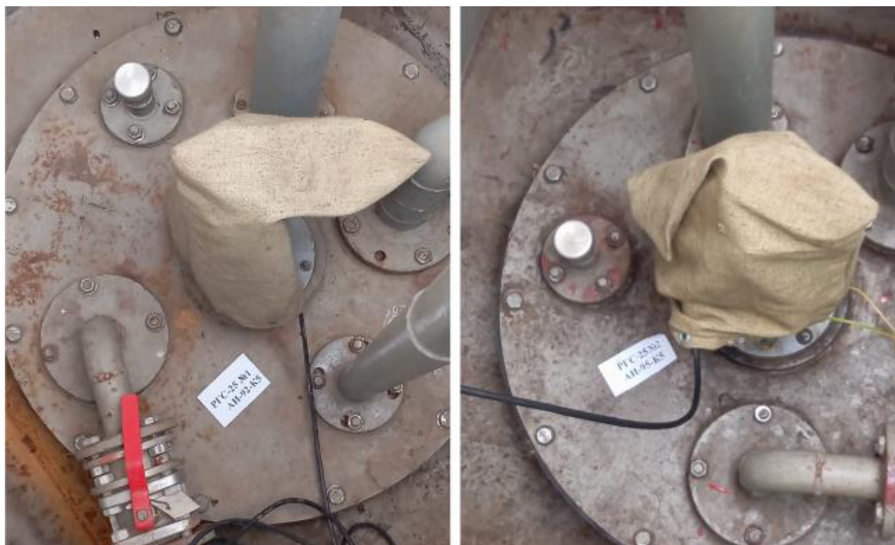
Рисунок 2 – Горловины резервуаров РГС-25 зав.№№ 1, 2
