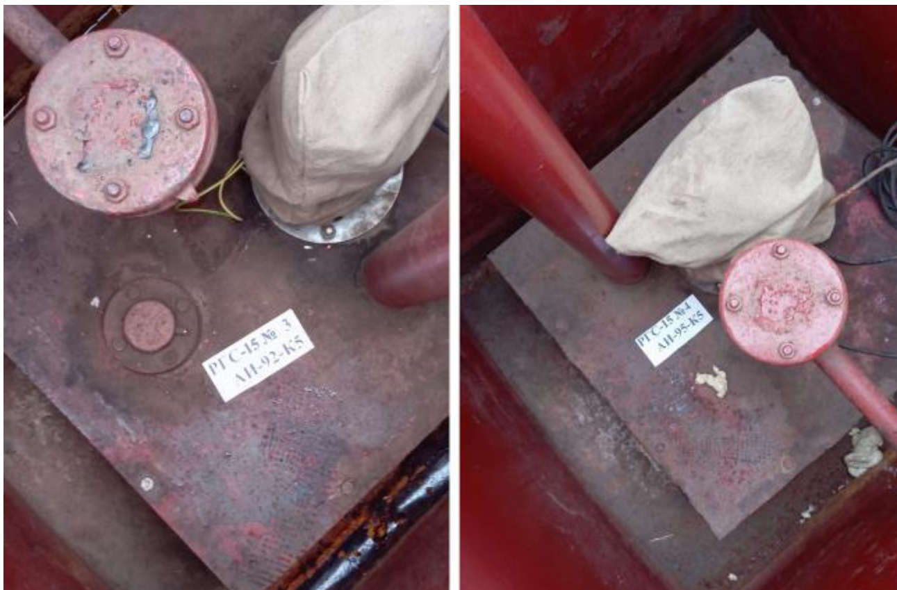
Рисунок 3 – Горловины резервуаров РГС-15 зав.№№ 3, 4
