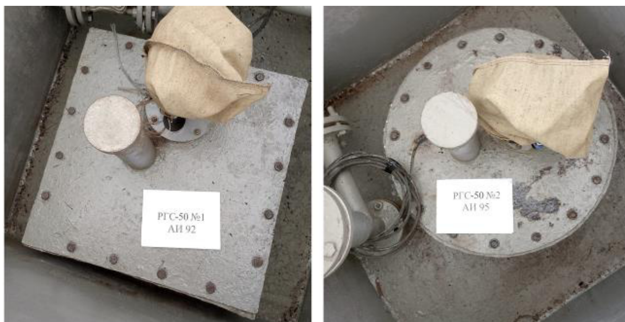
Рисунок 2 – Горловины резервуаров РГС-50 зав.№№ 1, 2
