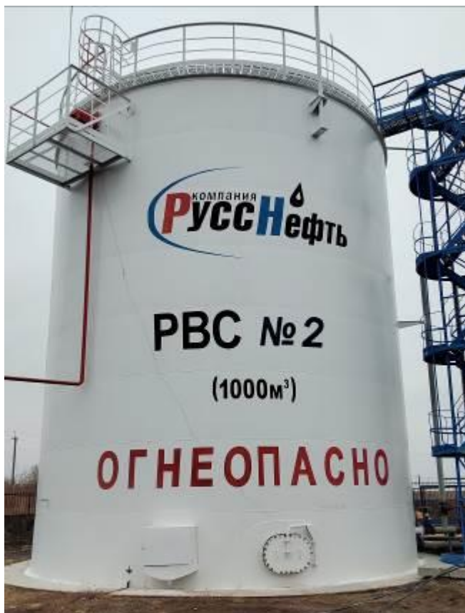
Рисунок 1 – Общий вид резервуара вертикального стального РВС-1000 заводской номер 2
