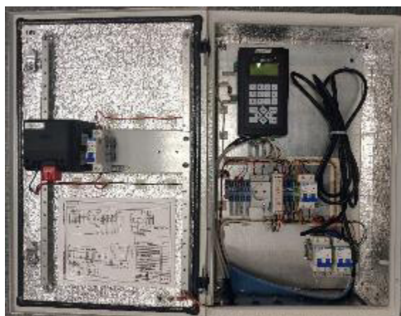
Рисунок 5 – Общий вид контроллера пылемера СОМ-16.М, смонтированного в металлическом корпусе с системой обогрева
