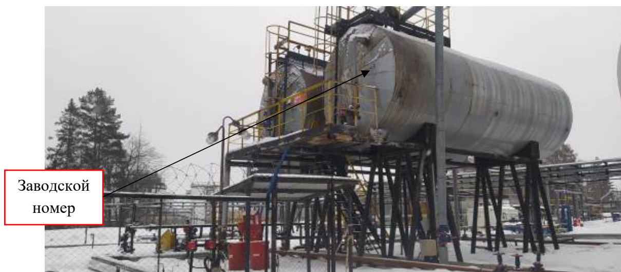
Рисунок 1 – Общий вид резервуара горизонтального стального цилиндрического РГС-75, заводской номер 5 с указанием места нанесения заводского номера
