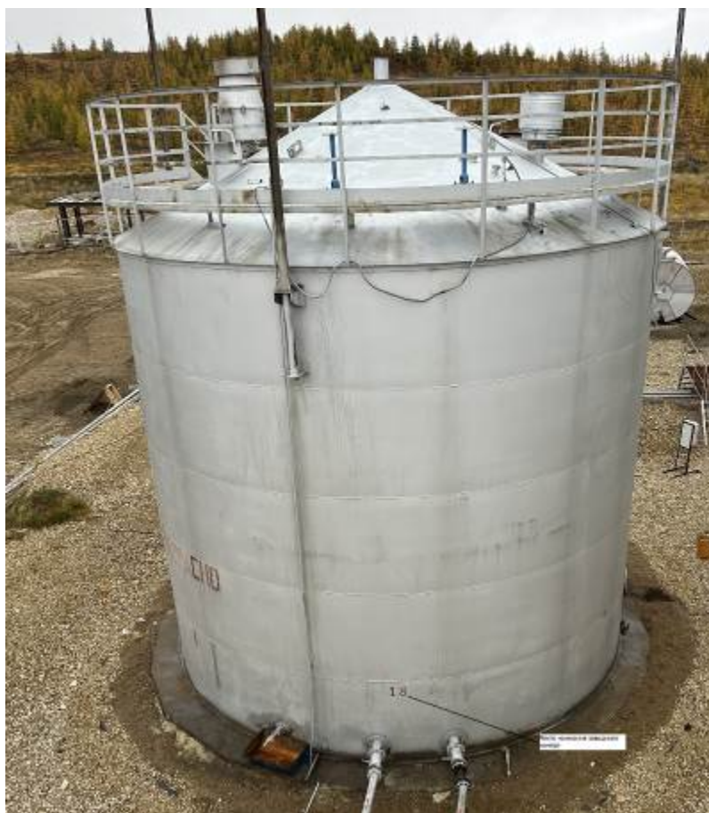
Рисунок 2 – Общий вид резервуара вертикального стального цилиндрического РВС, РВС-400 зав.№ 1.8 с указанием места нанесения заводских номеров
