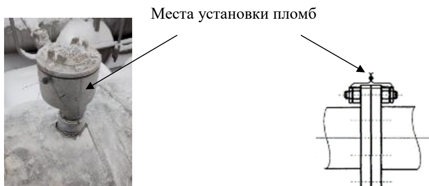
а) сигнализатор прохождения шарового поршня б) фланец калиброванного участка
