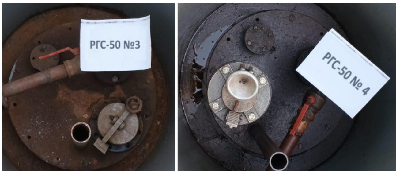
Рисунок 3 – Горловины резервуаров РГС-50 зав.№№ 3, 4
