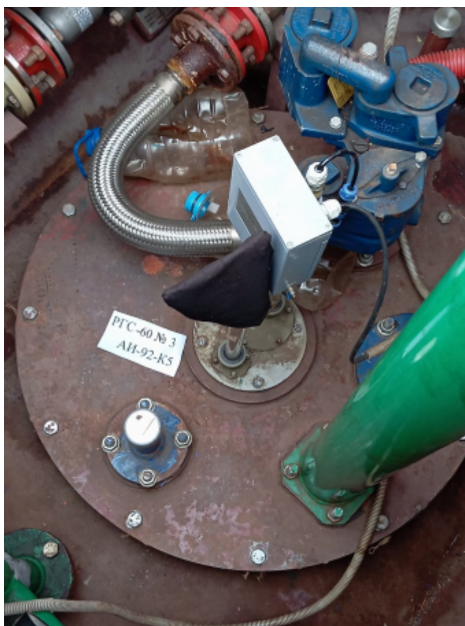
Рисунок 3 – Горловина резервуара РГС-60 зав.№ 3
