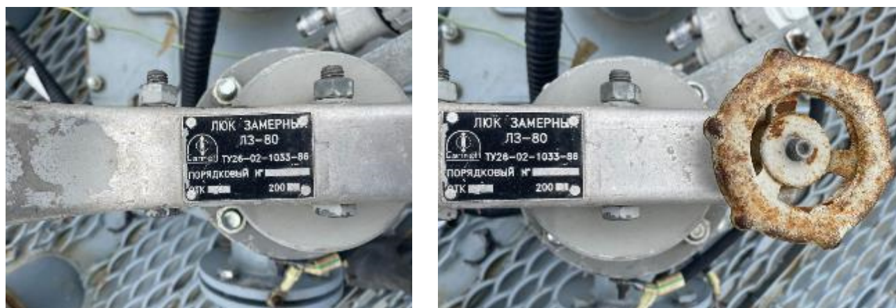
Рисунок 3 – Замерные люки резервуаров РГС-20
