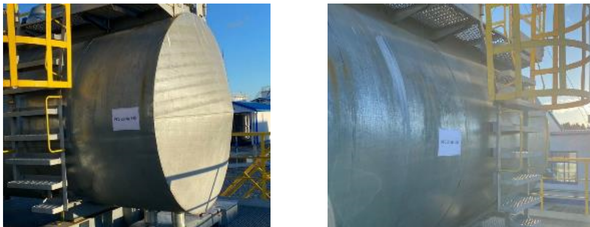
Рисунок 2 – Места нанесения заводских номеров резервуаров РГС-20
