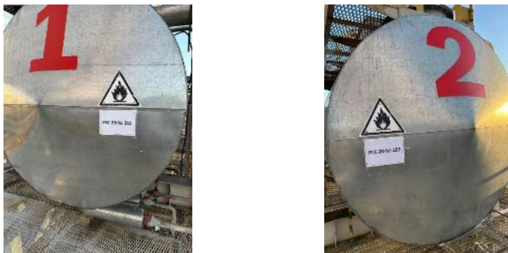
Рисунок 2 – Места нанесения заводских номеров резервуаров РГС-20
