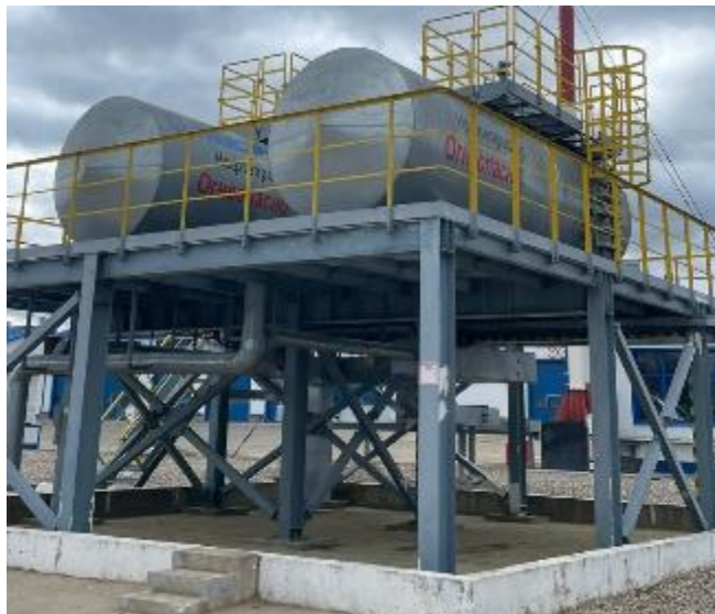
Рисунок 1 – Общий вид резервуаров РГС-20
