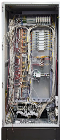
Рисунок 3 – Шкаф кроссовый. Вид сзади
