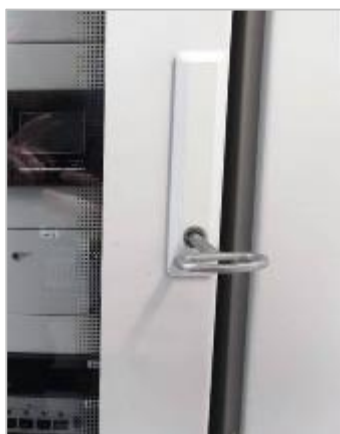
Рисунок 5 – Запирающий механизм стойки приборной
