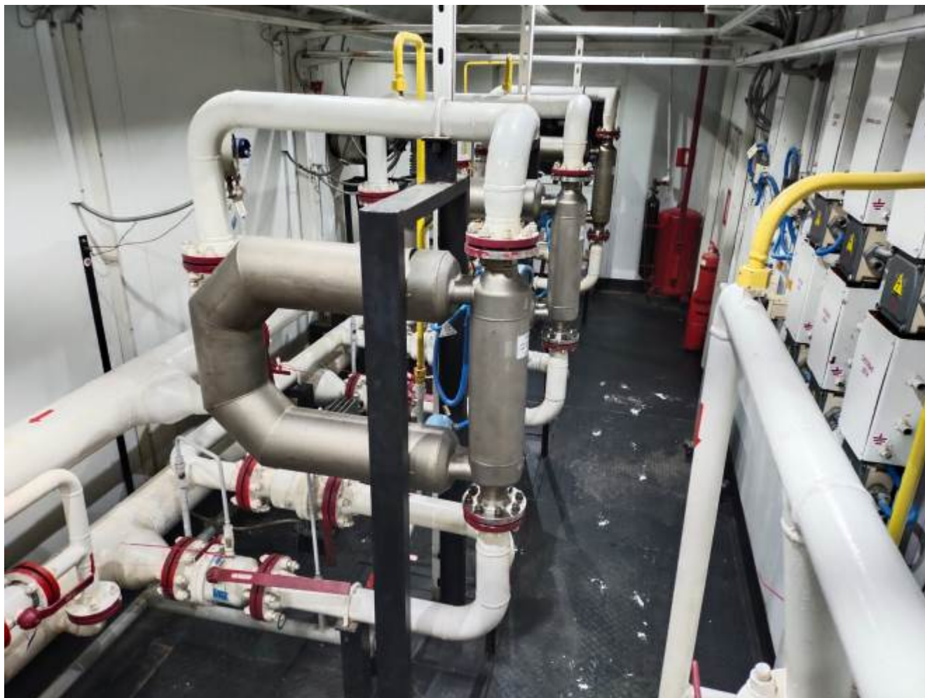
Рисунок 1 – Общий вид блока измерительных линий СИКНС
