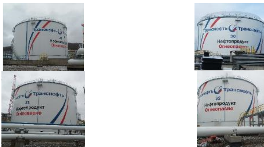
Рисунок 1 – Общий вид резервуаров РВСП-30000
