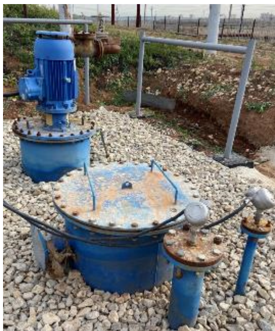
Рисунок 2 – Горловины и замерный люк резервуара
