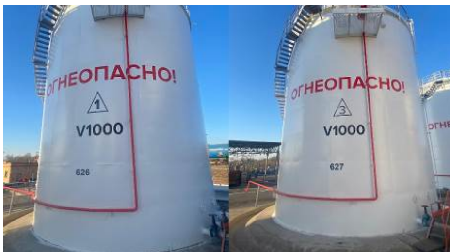
Рисунок 1 – Общий вид резервуаров вертикальных стальных цилиндрических РВС-1000 зав.№№ 626 (тех. 1), 627 (тех. 3) и место нанесения заводского и технологического номеров
