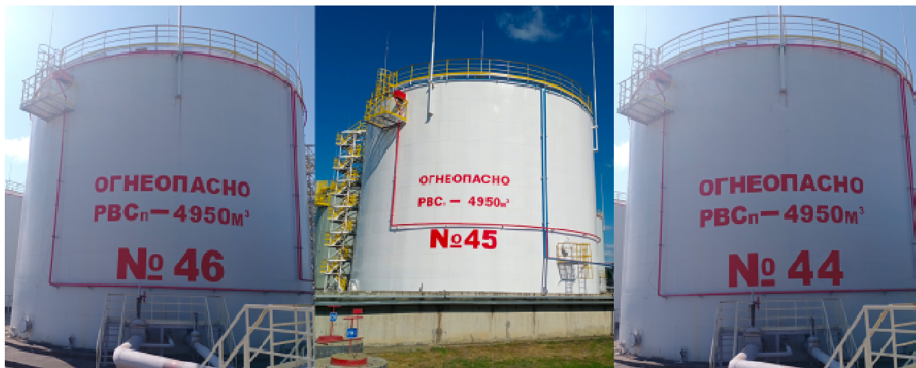
Рисунок 1 – общий вид резервуаров стальных вертикальных цилиндрических с понтоном РВСп-4950, заводские №№ 44, 45, 46
