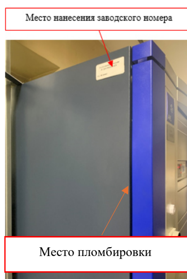
Рисунок 2 – Место нанесения заводского номера на шкафу системы управления PUMA
