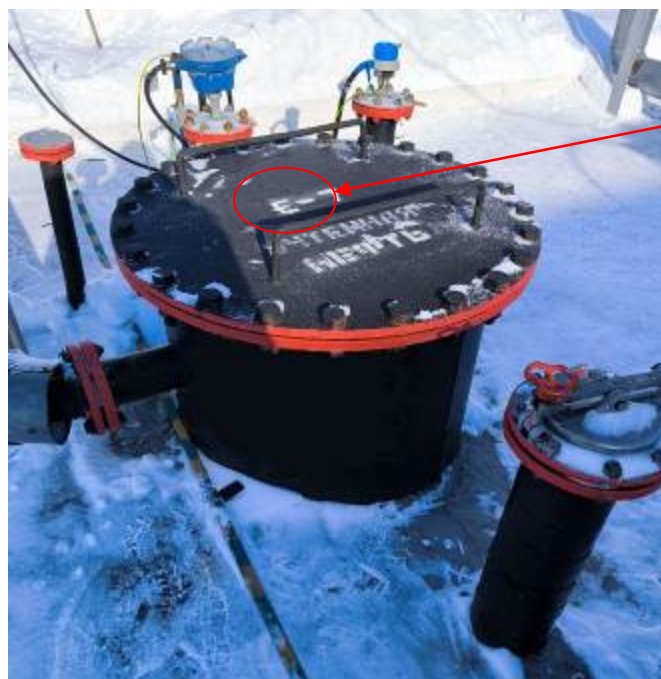
Рисунок 2 – Общий вид замерного люка РГС-12,5 зав.№ Е-7
