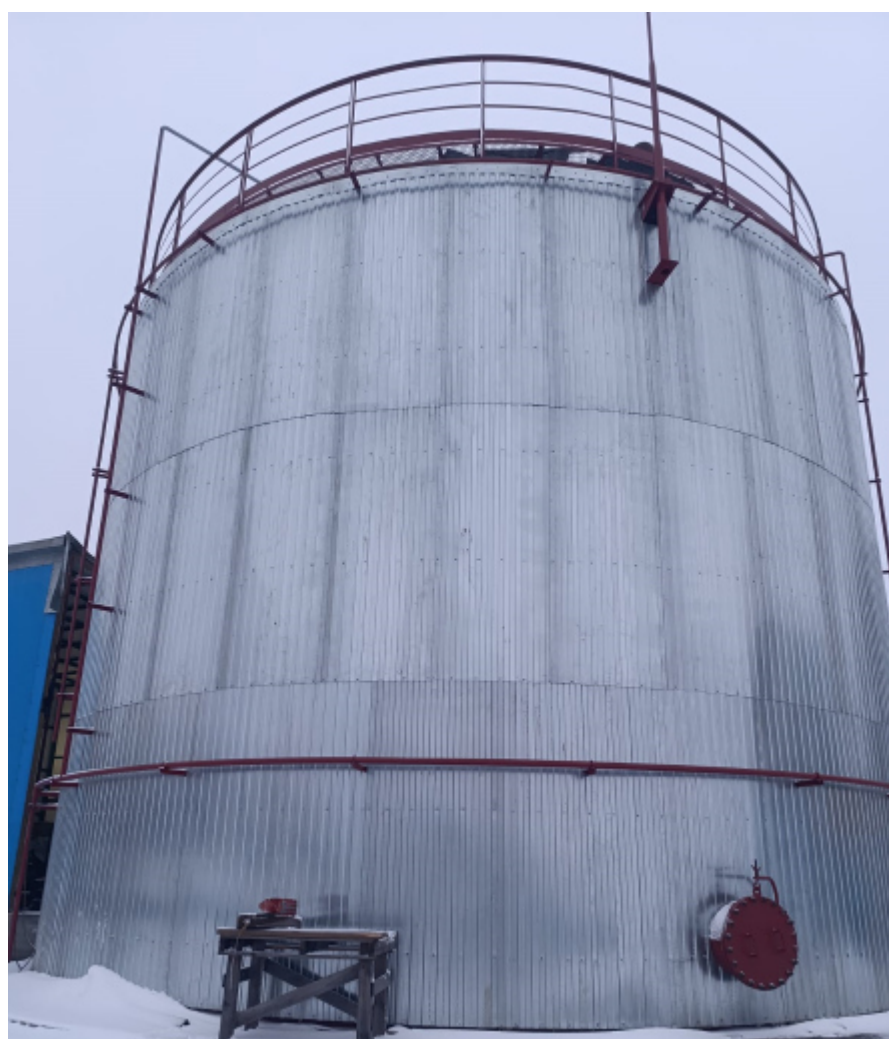
Рисунок 2 – Общий вид резервуара РВС-1000 с зав.№ 140
