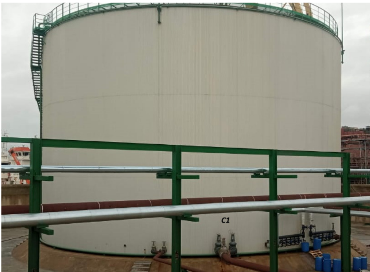
Рисунок 1 – Общий вид резервуара РВС-10000 с зав.№ С1
