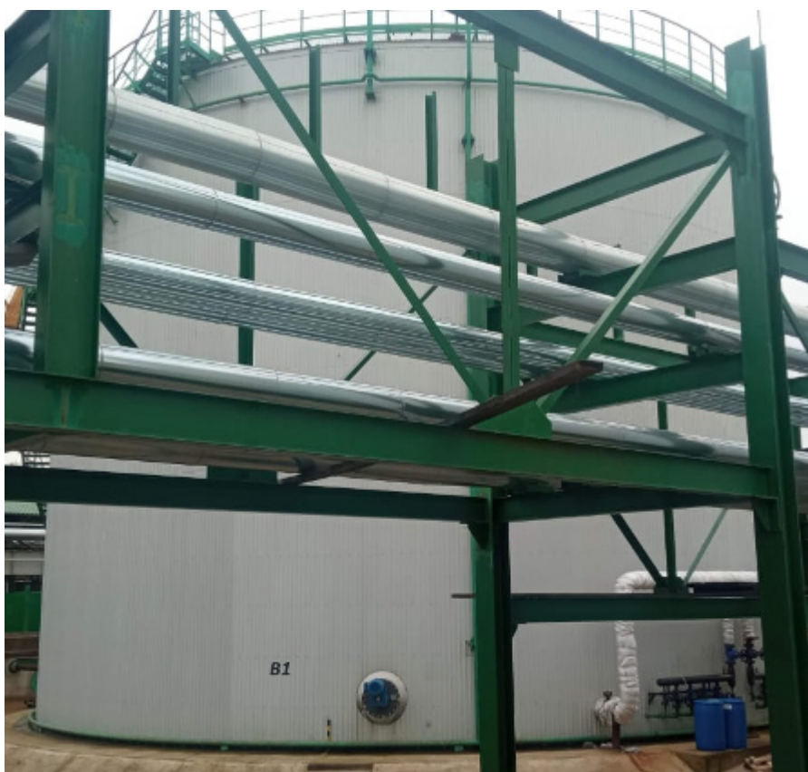
Рисунок 1 – Общий вид резервуара РВС-4900 с зав.№ В1
