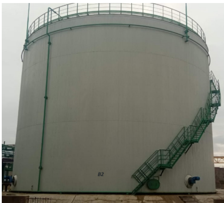
Рисунок 2 – Общий вид резервуара РВС-4900 с зав.№ В2
