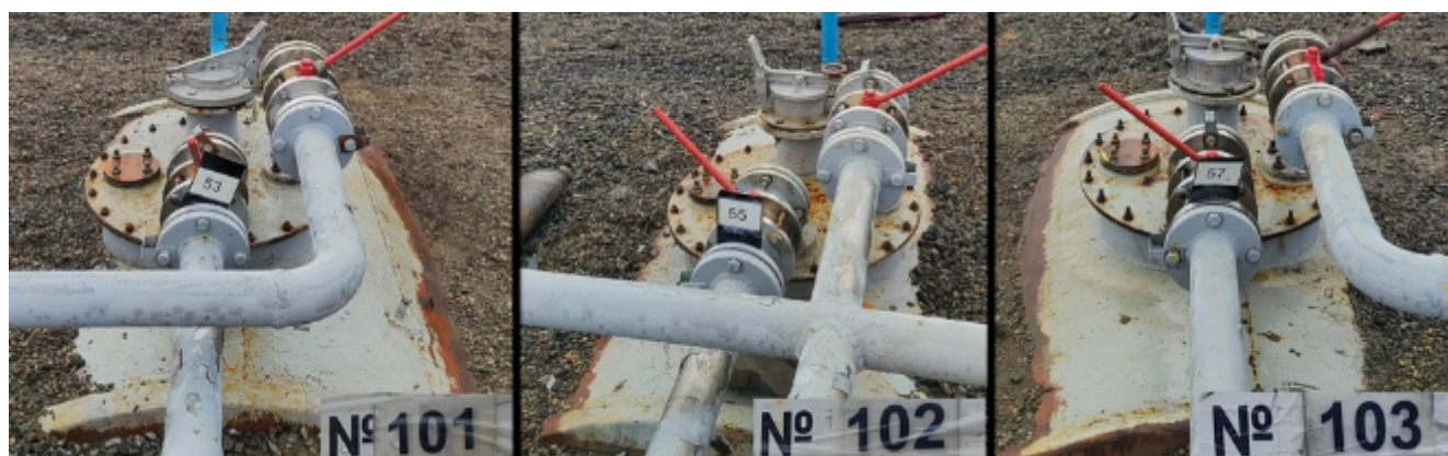
Рисунок 1 – Фотографии общего вида резервуаров стальных горизонтальных РГС-5 (№№ 101, 102, 103), их горловин замерного люка и заводских номеров.
