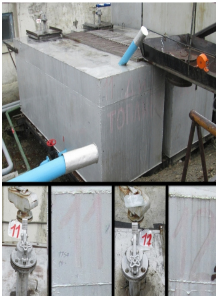
Рисунок 1 – Фотографии общего вида резервуаров стальных горизонтальных РГС-15 (№№ 11, 12), их горловин замерного люка и заводских номеров
