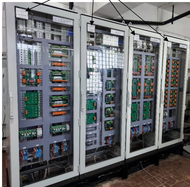
Рисунок 1 – Общий вид спереди: стойка управления системы ПАЗ (слева), шкафы управления №2 и №1 системы СУИ (в центре) и шкаф управления системы СУС (справа)
