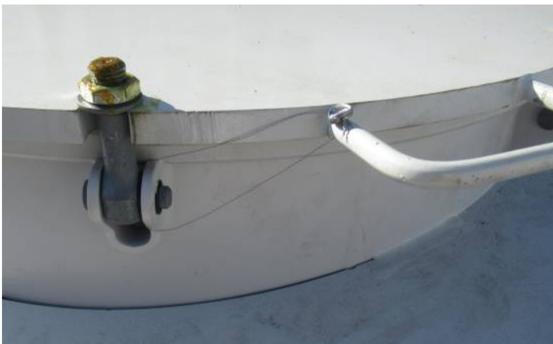
Рисунок 3 - Пломбировка горловины резервуара
