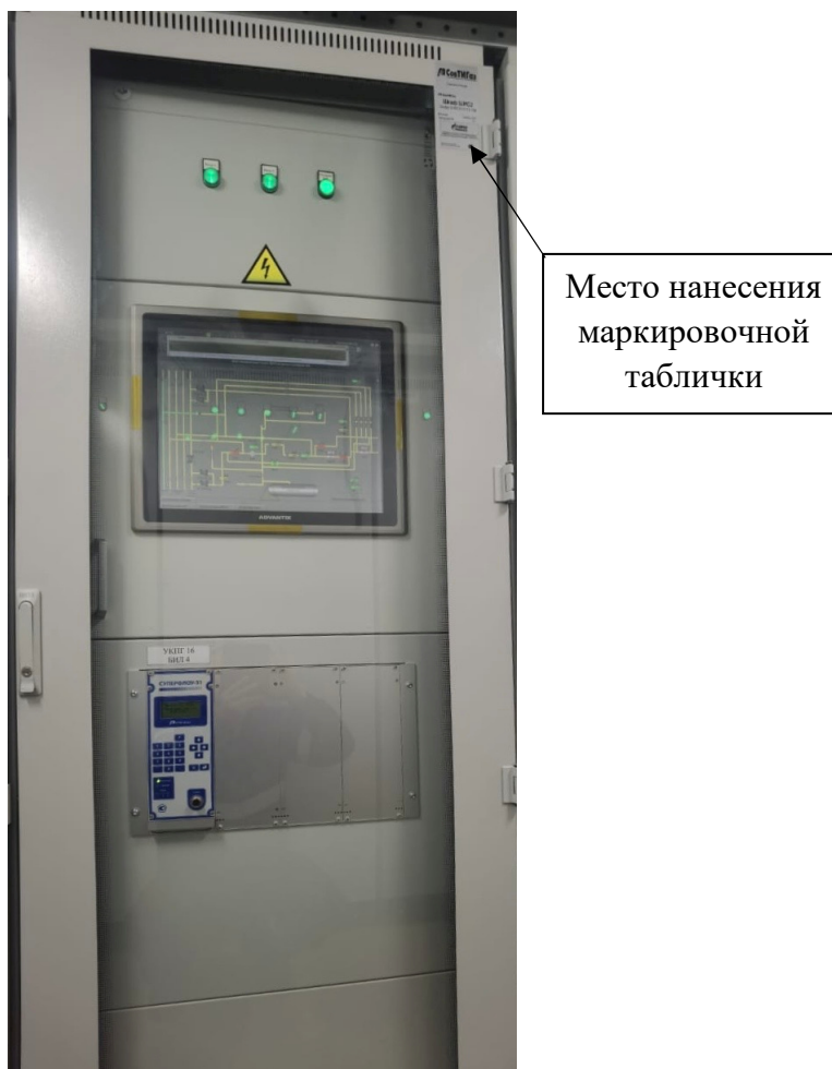
Рисунок 2 – Вид шкафа комплекса с указанием места нанесения маркировочной таблички
