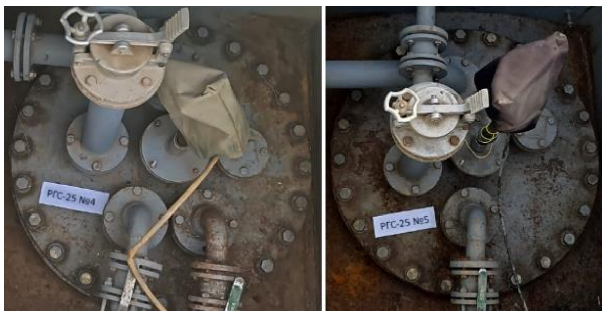
Рисунок 3 – Горловины резервуаров РГС-25 зав.№№ 4, 5
