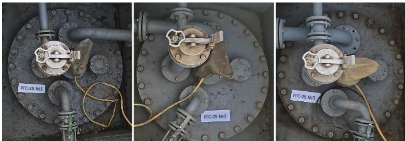
Рисунок 2 – Горловины резервуаров РГС-25 зав.№№ 1, 2, 3
