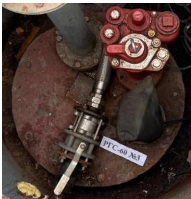
Рисунок 5 – Горловина резервуара РГС-60 зав.№ 3
