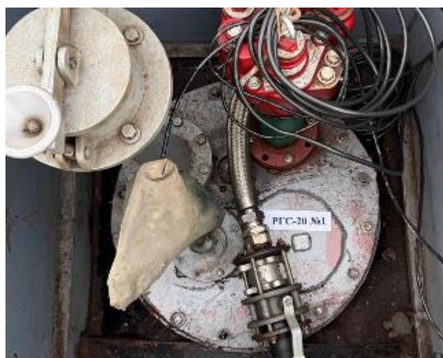
Рисунок 3 – Горловина резервуара РГС-20 зав.№ 1
