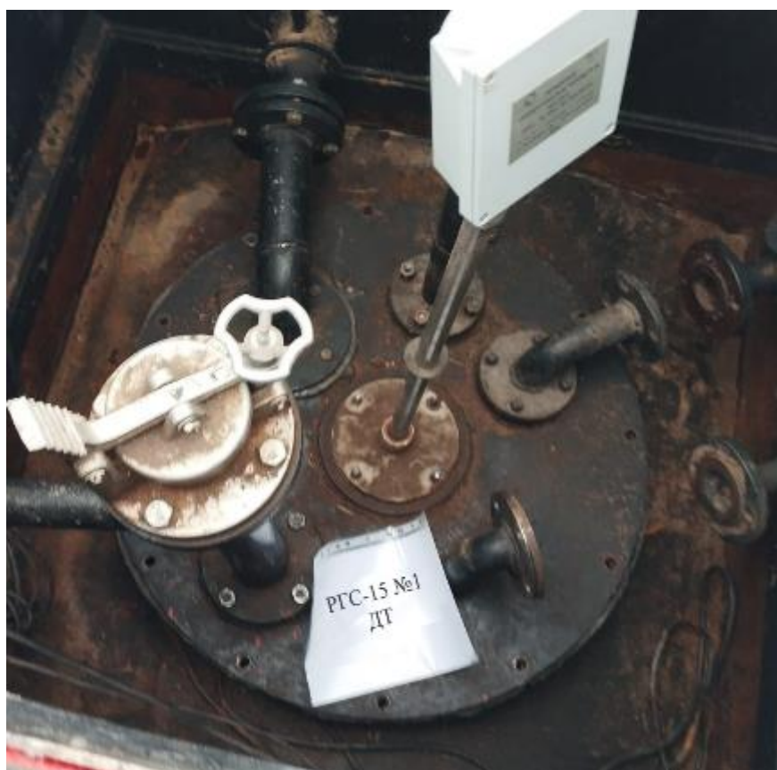
Рисунок 2 – Горловина резервуара РГС-15 зав.№ 1
