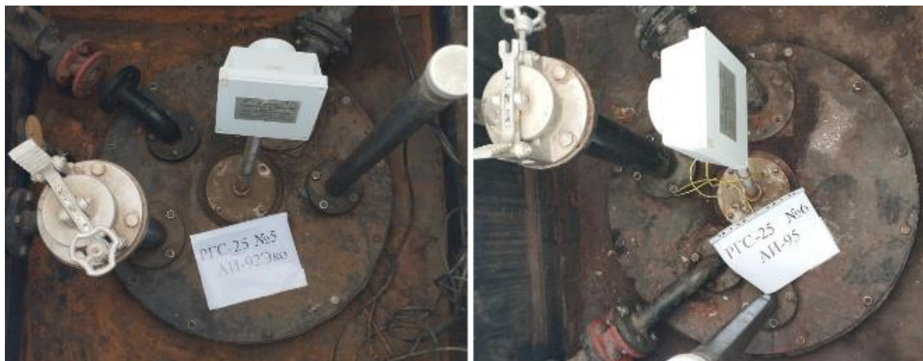
Рисунок 4 – Горловины резервуаров РГС-25 зав.№№ 5, 6
