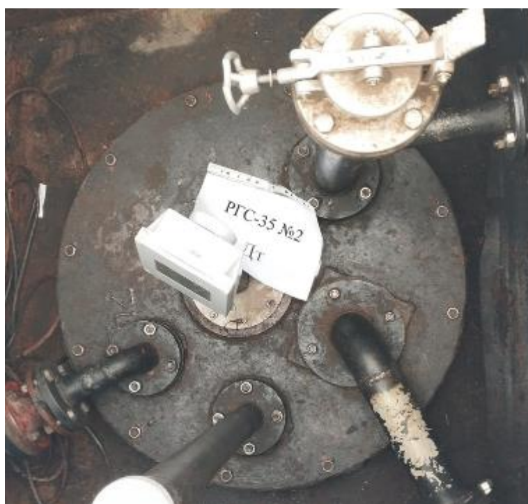
Рисунок 5 – Горловина резервуара РГС-35 зав.№ 2
