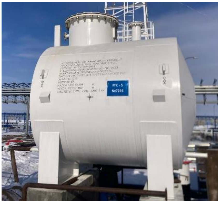
Рисунок 1 – Общий вид резервуара горизонтального стального РГС-5-А-СО-У1 заводской номер № 7295
