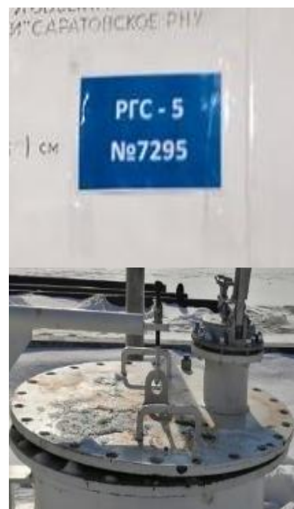
Рисунок 1 – Общий вид резервуара горизонтального стального РГС-5-А-СО-У1 заводской номер № 7295
