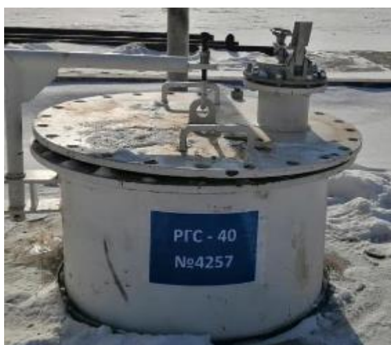
Рисунок 2 – Место нанесения заводского номера и место установки резервуара горизонтального стального подземного РГС-40-2400-1600-А-СО-У1 (заводской № 4257)
