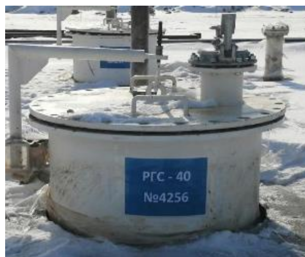
Рисунок 3 – Место нанесения заводского номера и место установки резервуара горизонтального стального подземного РГС-40-2400-1600-А-СО-У1 (заводской № 4256)
