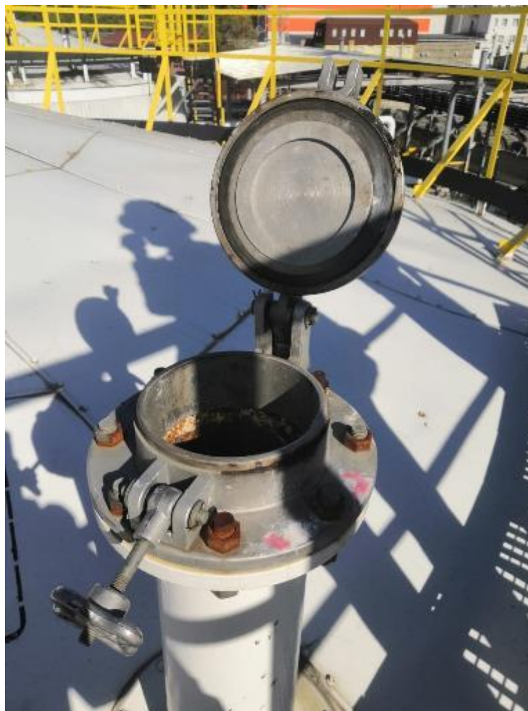
Рисунок 2 - Фотография горловины замерного люка резервуара вертикального стального цилиндрического РВС-10000 заводской № 35
