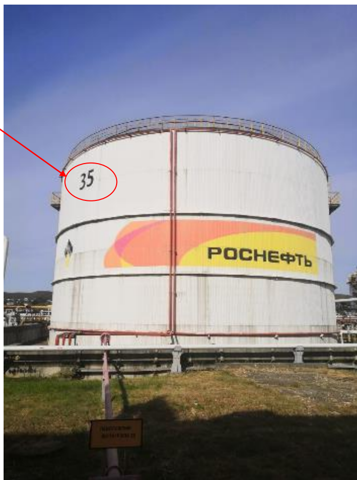
Рисунок 1 – Фотография общего вида резервуара вертикального стального цилиндрического РВС-10000 заводской № 35
