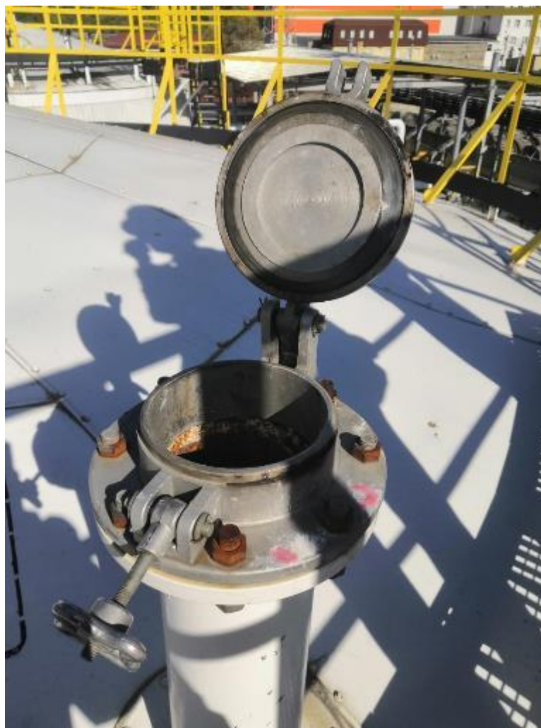
Рисунок 2 – Фотография горловины замерного люка резервуара вертикального стального цилиндрического РВС-20000 заводской № 34
