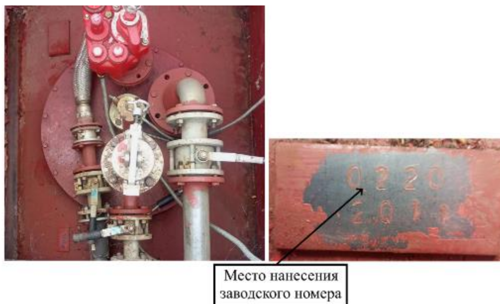
Рисунок 2 – Горловина и измерительный люк резервуара РГП 25-1-1-О-У зав.№ 0220
