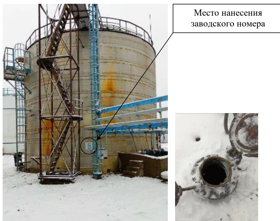
Р и с у н о к 2 – Общий вид резервуара с заводским номером 5 и его замерного люка
