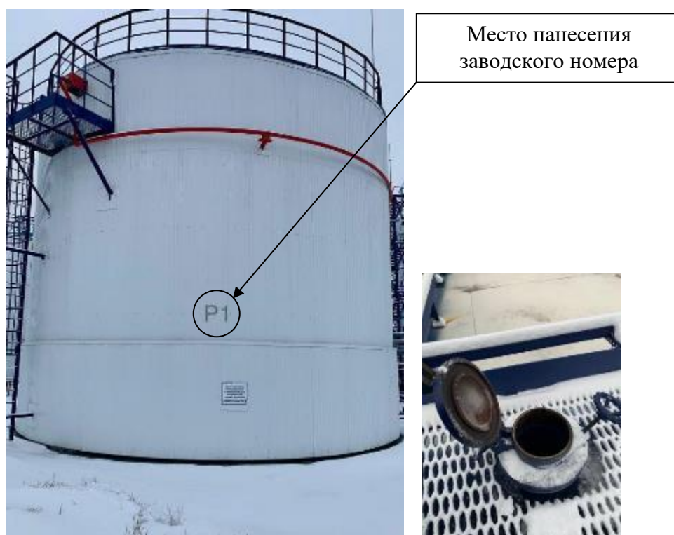
Р и с у н о к 1 – Общий вид резервуара с заводским номером P1 и его замерного люка
