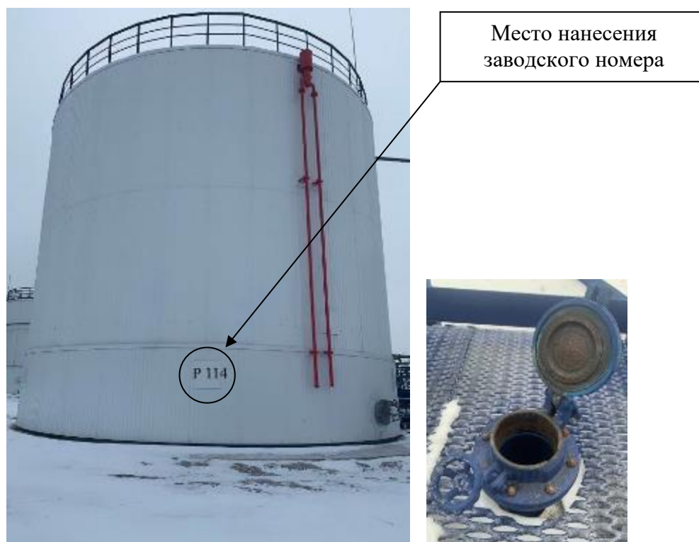
Р и с у н о к 7 – Общий вид резервуара с заводским номером Р114 и его замерного люка
