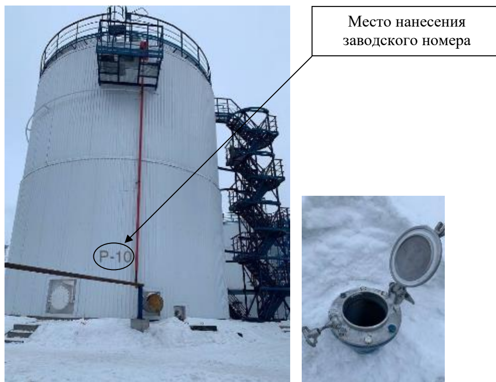
Р и с у н о к 3 – Общий вид резервуара с заводским номером Р-10 и его замерного люка
