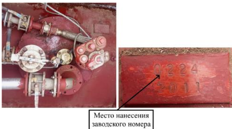
Рисунок 8 – Горловина и измерительный люк резервуара РГП 25-1-2(0,85)-О-У зав.№ 0224
