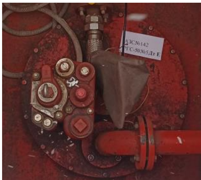
Рисунок 4 – Горловина резервуара РГС-50 зав.№ 5
