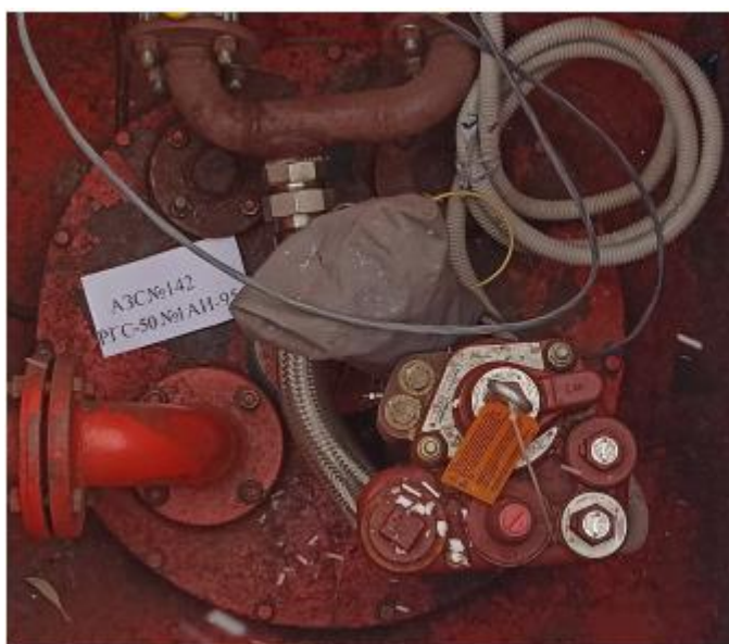
Рисунок 2 – Горловины резервуаров РГС-50 зав.№№ 1, 2
