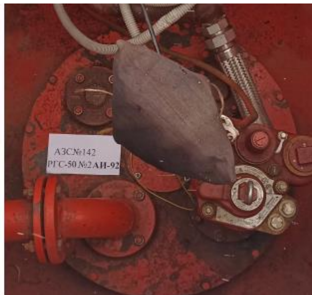
Рисунок 2 – Горловины резервуаров РГС-50 зав.№№ 1, 2
