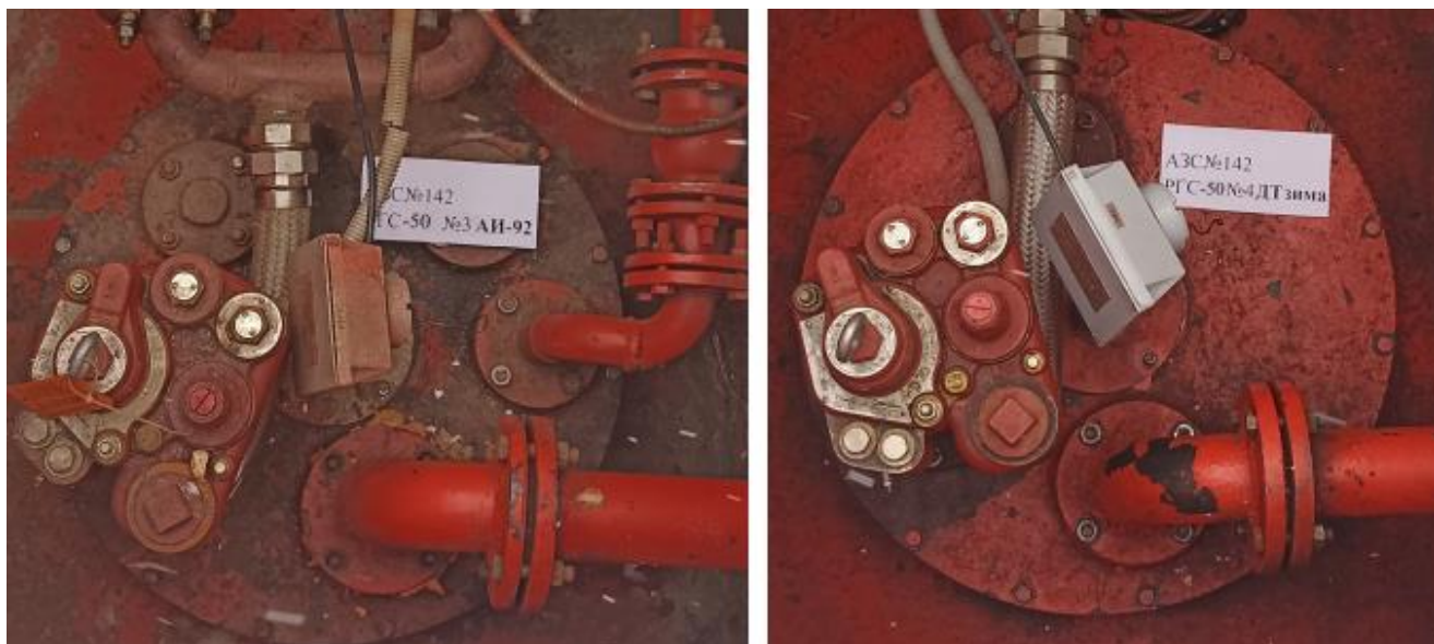
Рисунок 3 – Горловины резервуаров РГС-50 зав.№№ 3, 4
