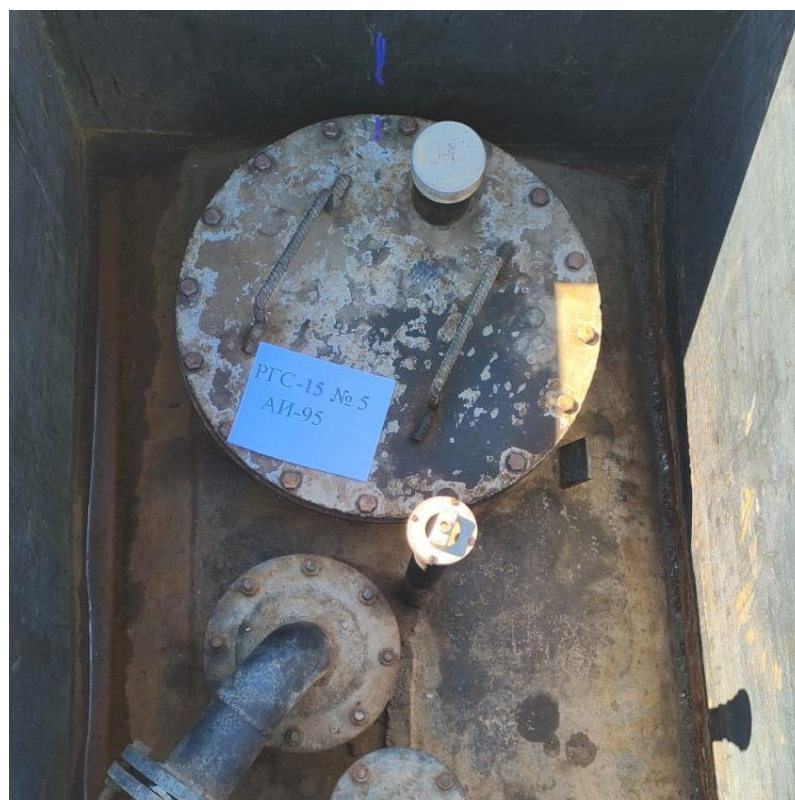
Рисунок 4 – Горловина резервуара РГС-15 зав.№ 5
