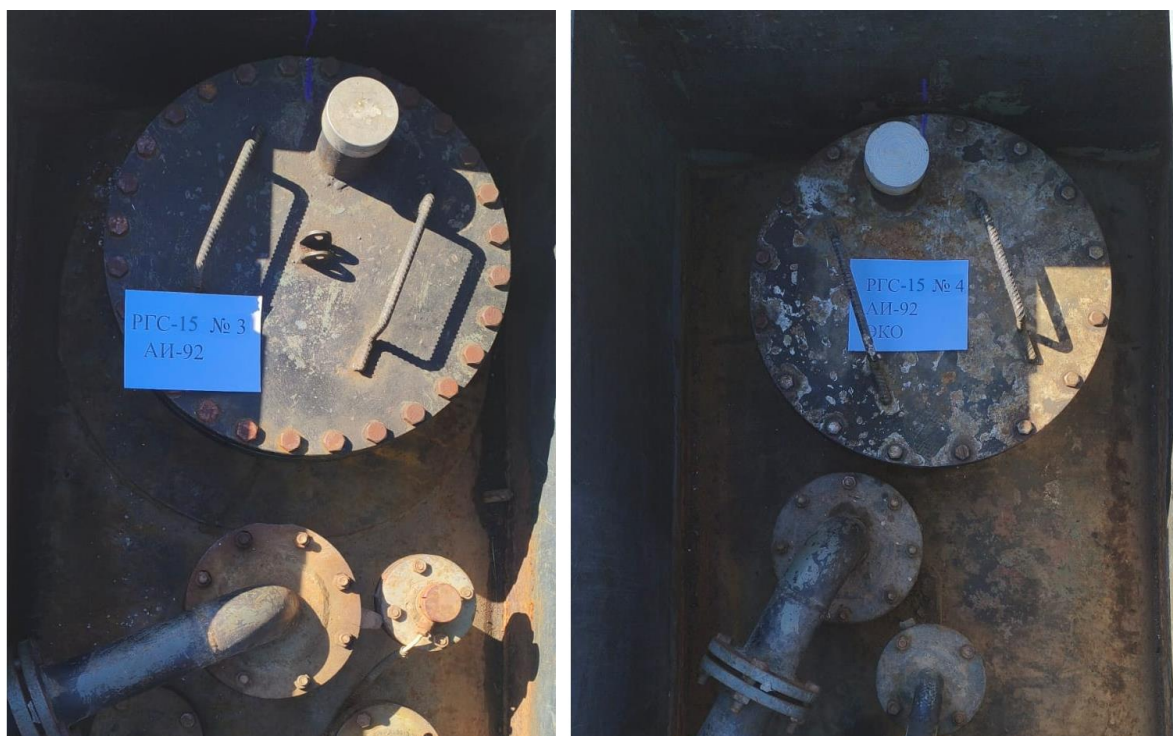
Рисунок 3 – Горловины резервуаров РГС-15 зав.№№ 3, 4
