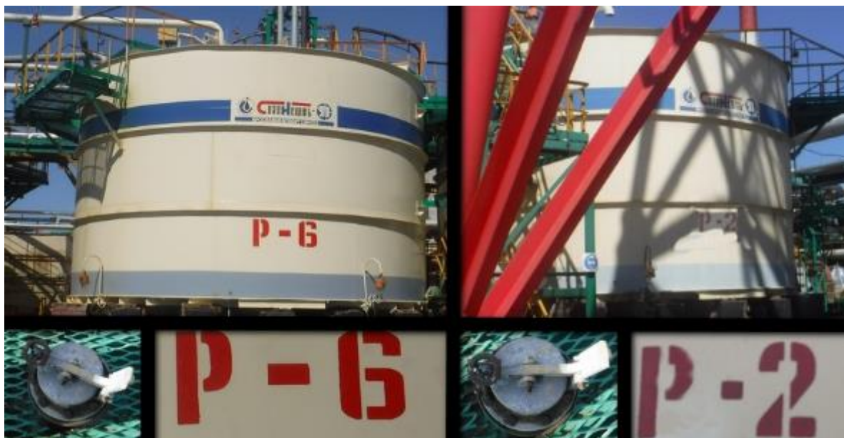
Рисунок 1 – Фотографии общего вида резервуаров стальных вертикальных цилиндрических РВС-300 (№№ Р-2, Р-6), горловин замерных люков и заводских номеров
