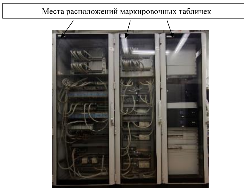
Рисунок 2 – Внешний вид электротехнических шкафов СИ В1 с указанием мест расположений маркировочных табличек
